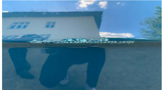
Schadendokumentation: Seitenwand - Hinten - Rechts
