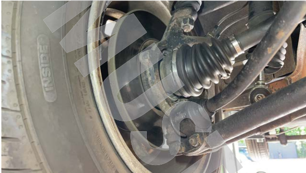
Dokumentation Fahrzeugprüfung: Bremsanlage
